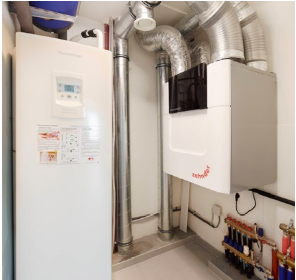
Warmtepompinstallatie
