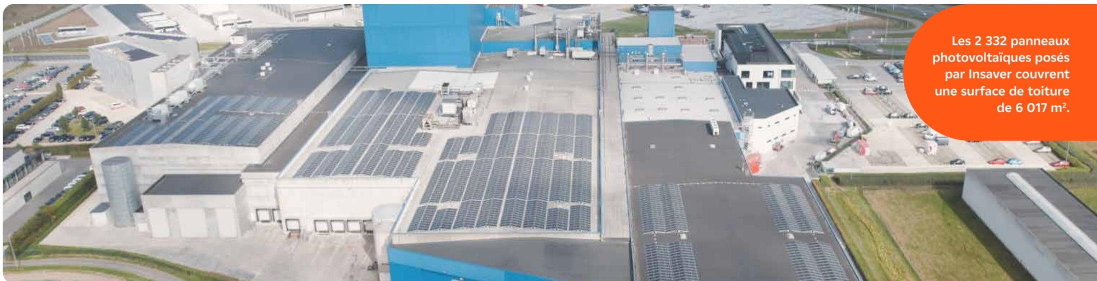
Les 2 332 panneaux photovoltaïques posés par Insaver couvrent une surface de toiture de 6 017 m<sup>2</sup>.
