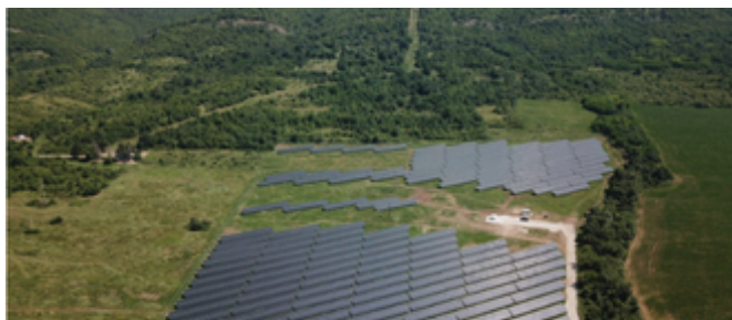
Centrale photovoltaïque solaire à la cimenterie de Zlatna Panega, Bulgarie.
