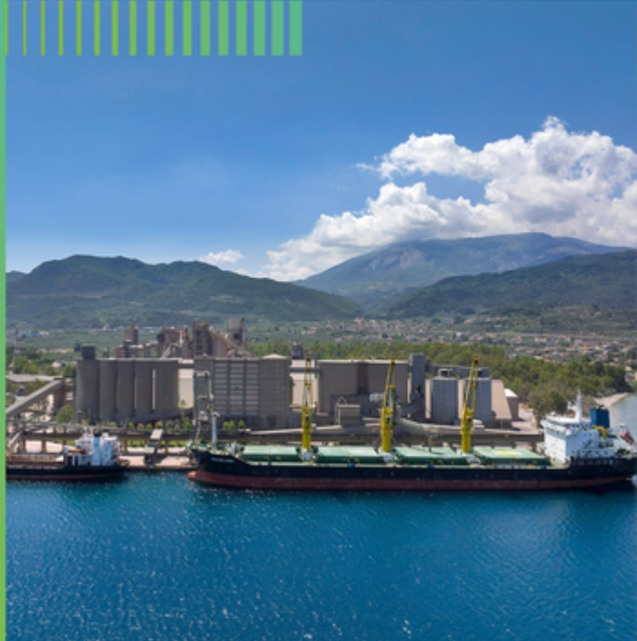
Cimenterie de Patras, Grèce
