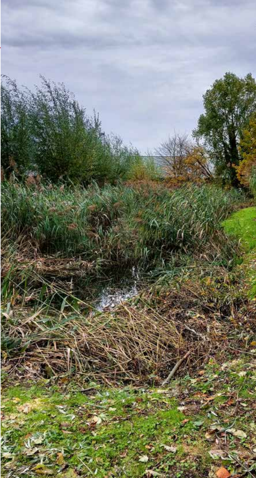
Infiltratie van overtollig regenwater in een wadi
