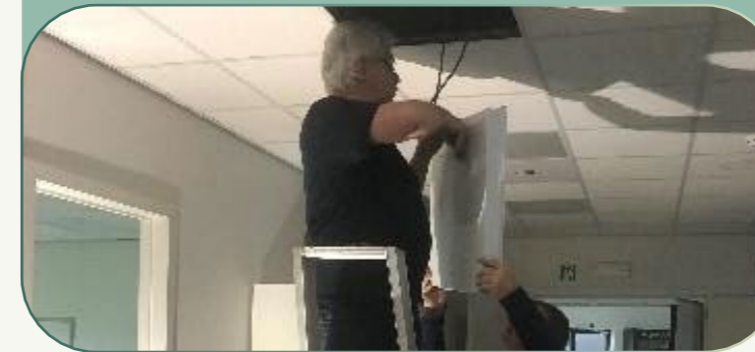
PLAATSING LED-VERLICHTING
