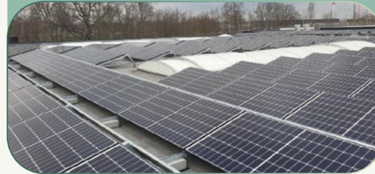
INSTALLATION DE PANNEAUX SOLAIRES
